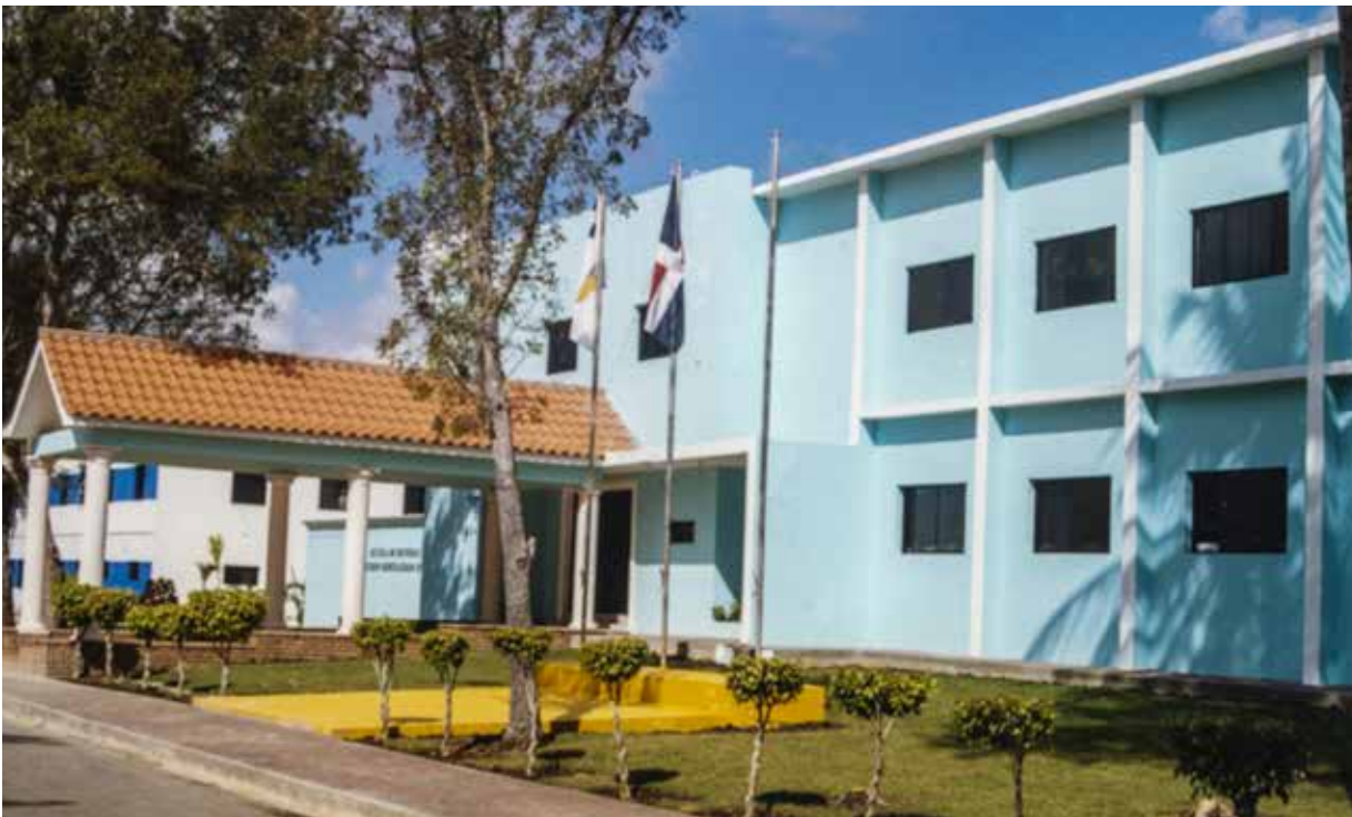
Remodelación de la Escuela de Seguridad en el periodo 2002-2004
