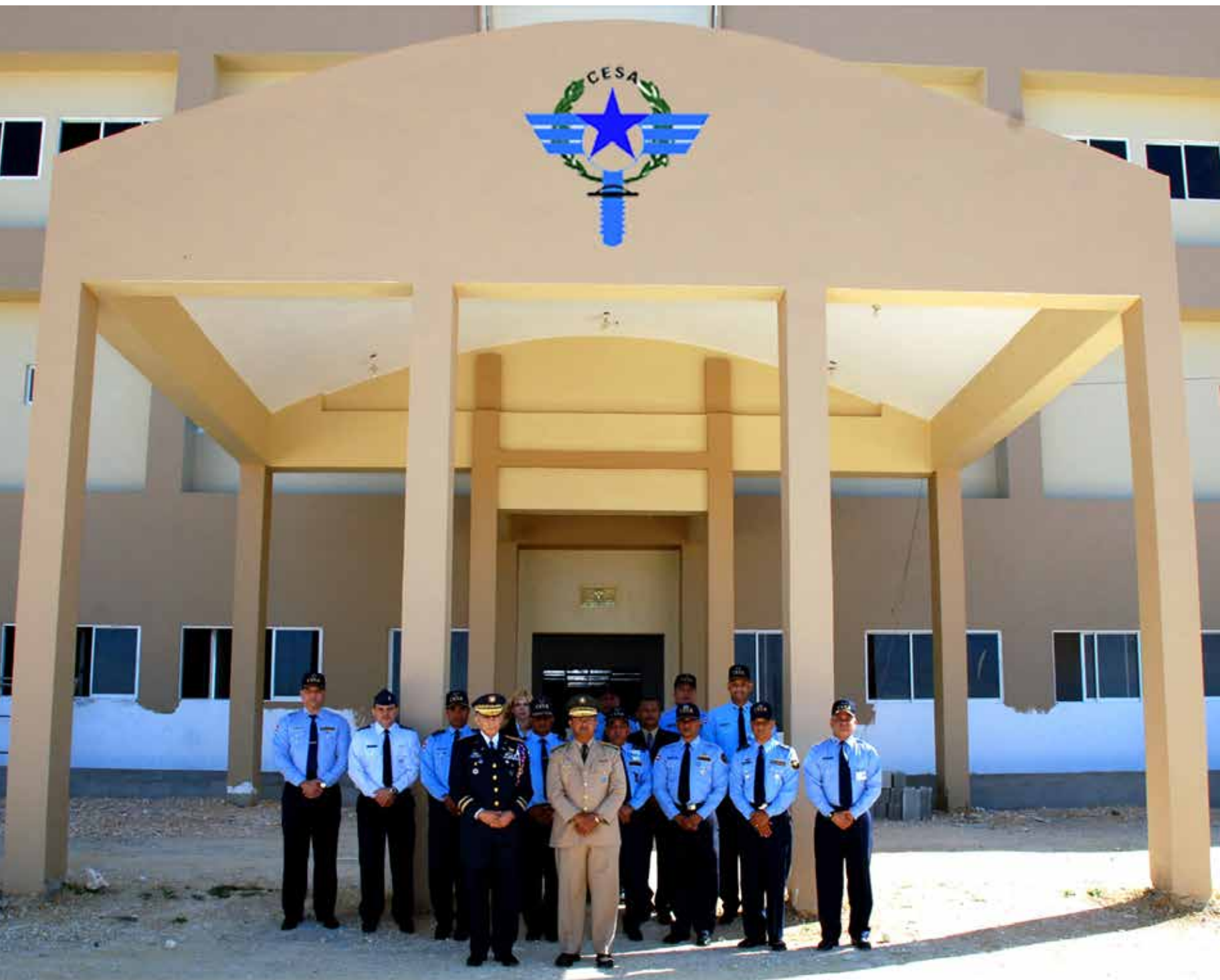
En la gestión del Mayor General Piloto, Juan Bautista Rojas Tabar, FAD. (02 marzo 2006 - 16 agosto 2008) se continúa la construcción y se finaliza el edificio “Mayor General Piloto Juan Bautista Rojas Tabar, FAD. (DEM)” sede actual del CESAC.
